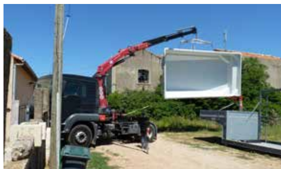
LIVRAISON DE LA PISCINE
