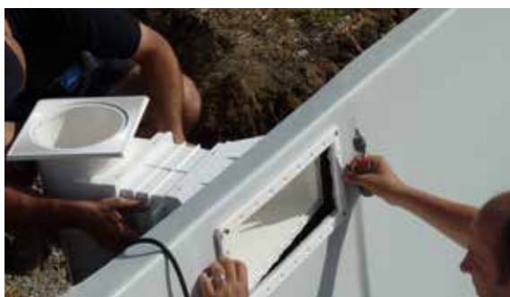
MISE EN PLACE DES PIÈCES À SCELLER
