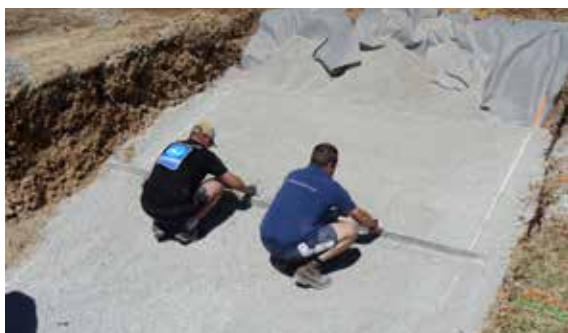
PRÉPARATION ASSISE DRAINANTE
